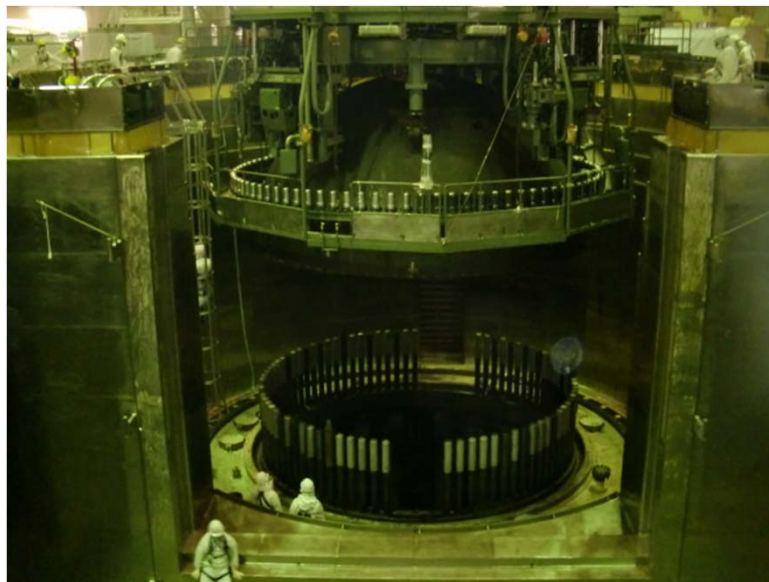
【参考】福島第一6号機の原子炉圧力容器の蓋取り外しの様子 (平成25年10月5日撮影)
