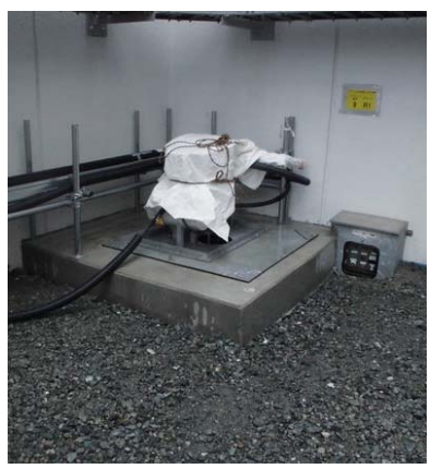
サブドレンピット
