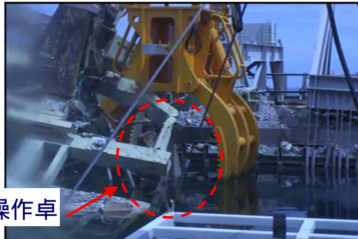
写真 爪 5 本で撤去しようとした状況 (西側 側方より撮影)
