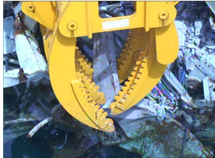
写真 爪 2 本での把持状況 (南側より撮影)
