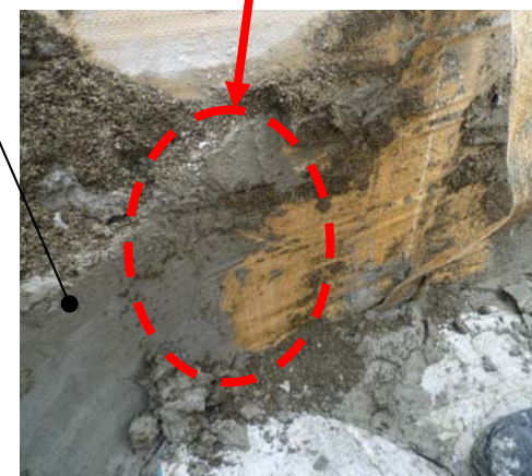
土嚢の間の狭い隙間にも材料が充填されている
