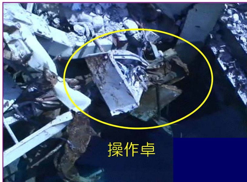
撤去前の操作卓の状況 (南側 上方より撮影)
