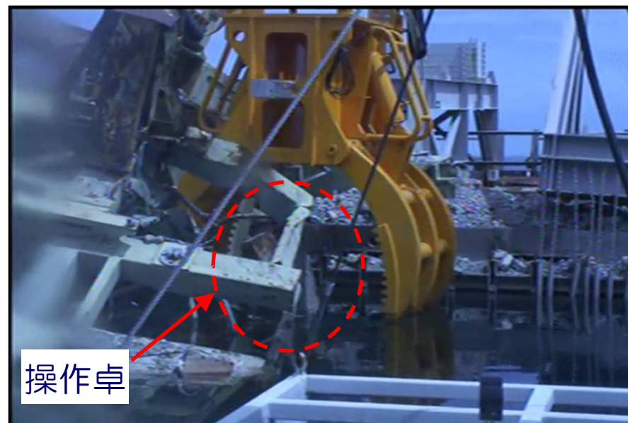
撤去中の状況 (西側 側方より撮影)
