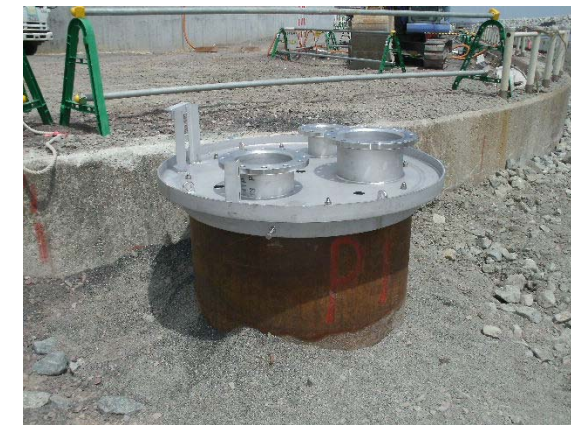
地下水ドレンピット設置状況 (1号取水口前)
