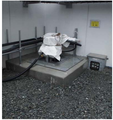
サブドレンピット
