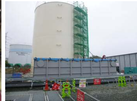
サンプルタンク設置状況
