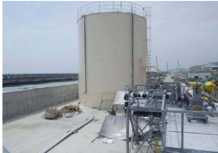
集水タンク設置状況
