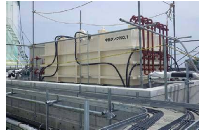
No1中継タンク設置状況
