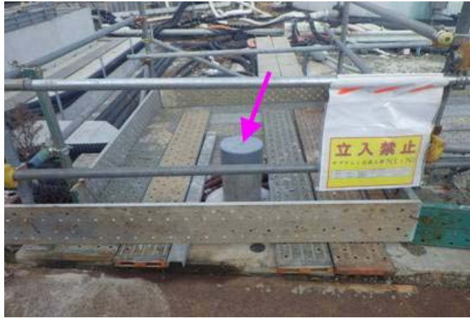
新設サブドレンピットN1（掘削完了）
