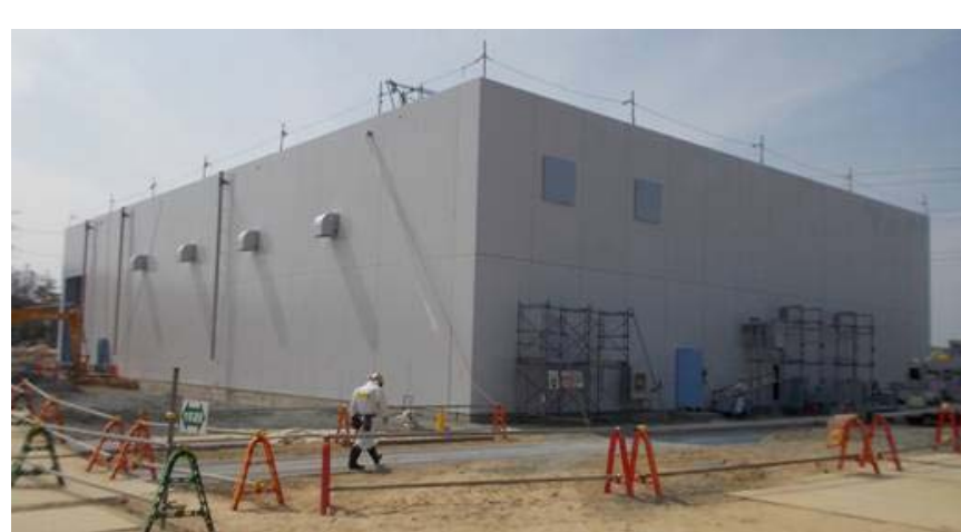
建屋外観（南東面）
