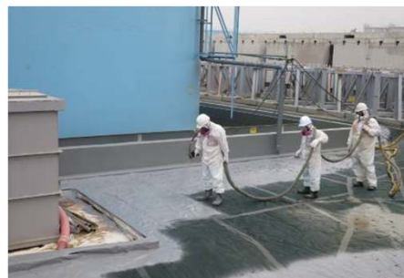
堰内被覆作業
