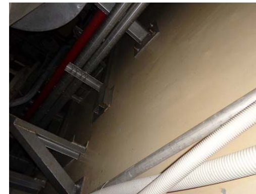
② 南面（内壁）
