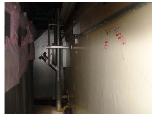
④ 西面（内壁）
