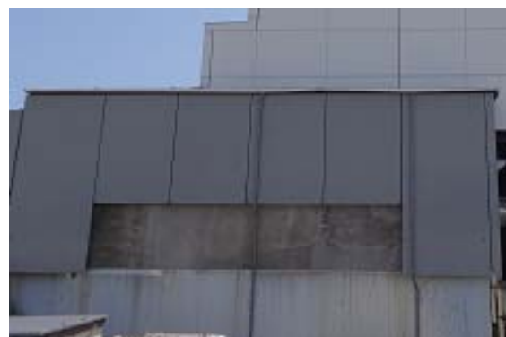
⑤ 西面（外壁）
