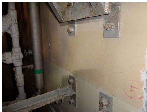
① 西面（内壁）
