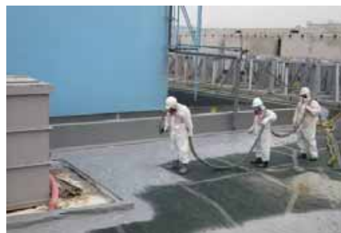
堰内被覆作業
