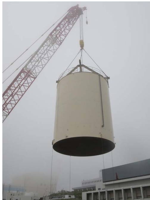
吊り上げ (1基目)
