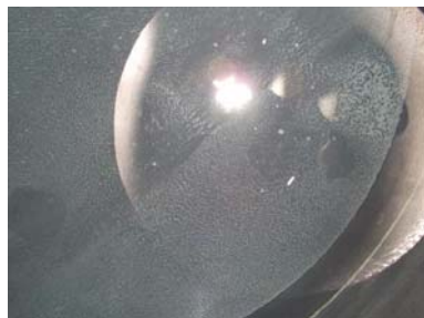
吸着塔2 A 吸着材4（黒色）の上に白 い堆積物を確認
