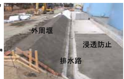
タンク周辺地表面のフェーシング実施状況
