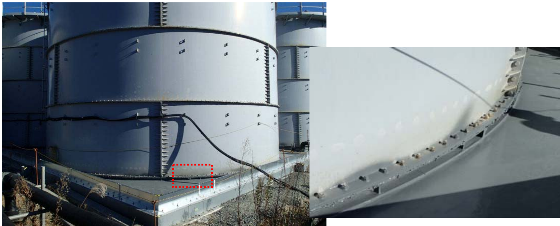
実機の施工状況
