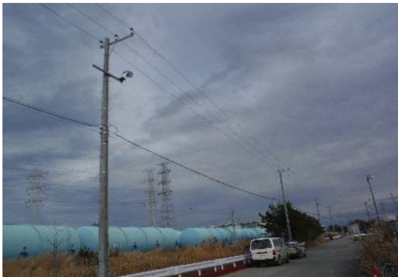
区間-D 配電線、照明設置状況
