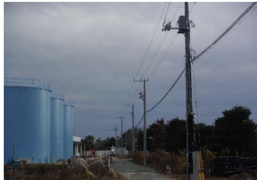
区間-E 配電線、照明設置状況
