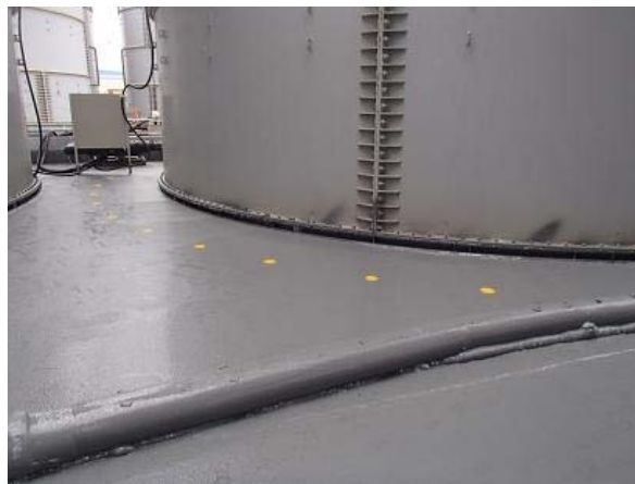
現場への動線マーキング
