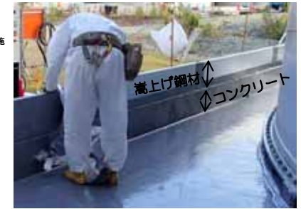
鋼製板による堰の嵩上げ実施状況
