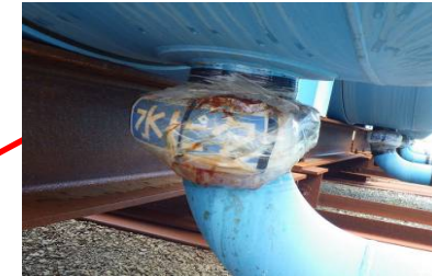
吸水ポリマー施工状況
