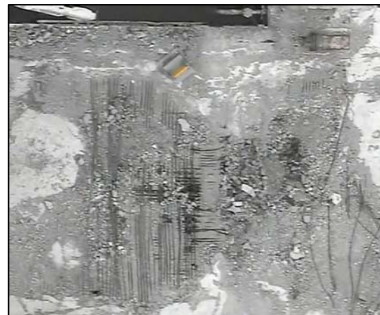
写真②コンクリート上端の損傷により鉄筋が露出
