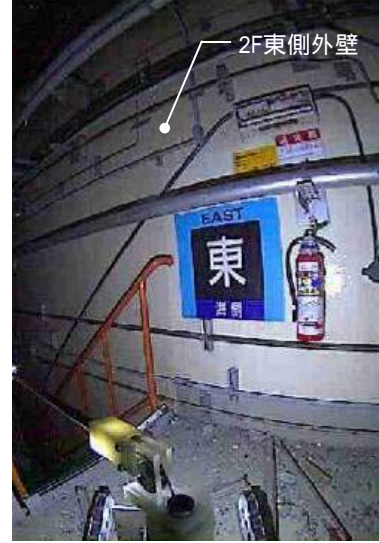
2F階段口東側外壁
