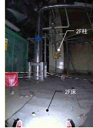
2F床及び中間部の柱
