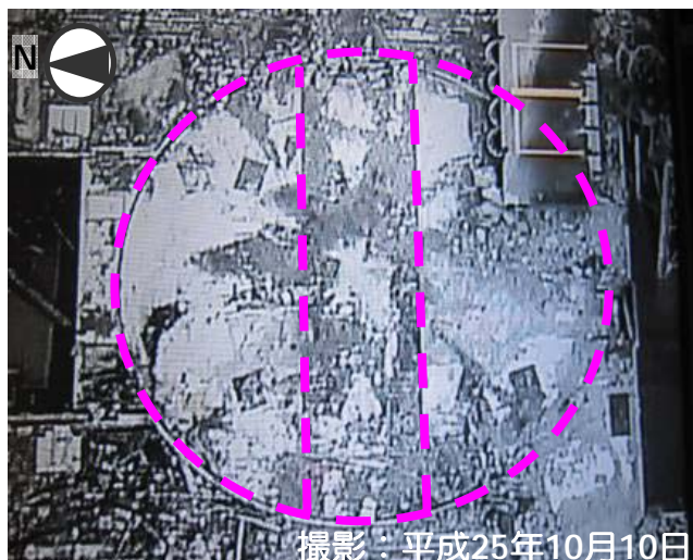
除染作業開始前
