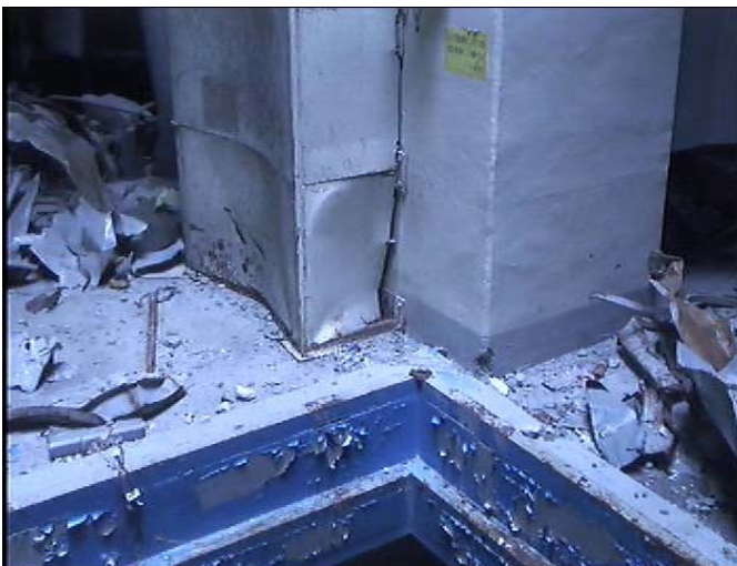
③ 2F柱脚部及び床上状況
