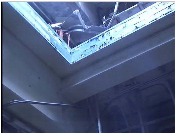
① 3F大梁交差部
