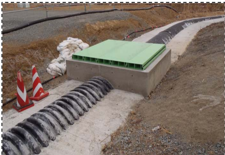
①ダブルパイプ設置状況 (撮影日H26.1.16)
