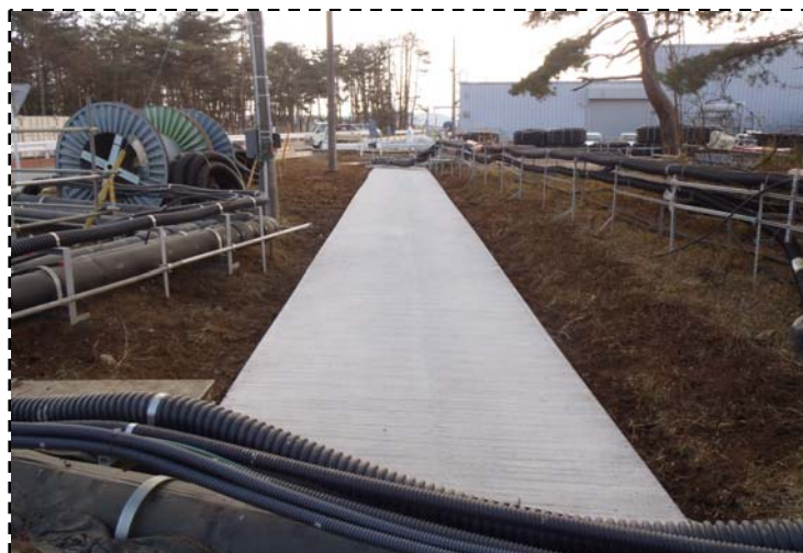
③コンクリート蓋設置状況 (撮影日H26.1.22)
