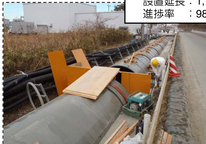
②FRP管設置状況 (撮影日H26.1.15)
