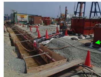
ウェルポイント(くみ上げ井戸)の敷設状況
