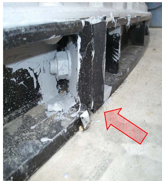
タンク底板フランジ接合部写真
