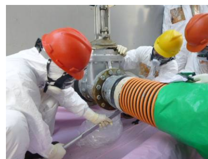
フランジ増し締め作業状況
