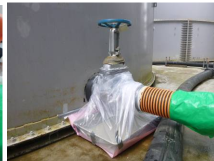
漏えい停止確認後の養生状況
