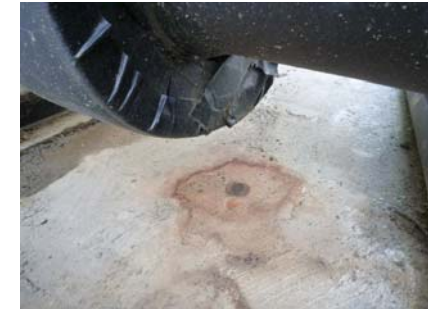
H5-IV-No.5タンク 出口弁フランジ(8/31)
