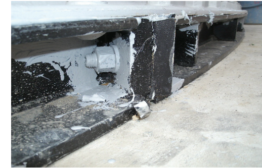
タンク底板フランジ接合部写真
