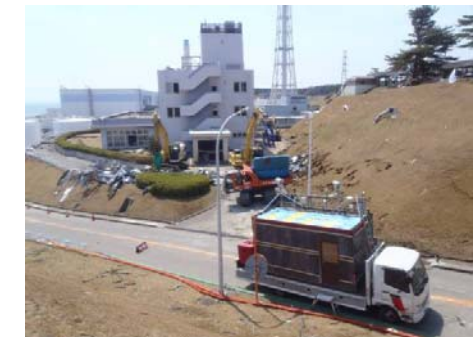
操作車と作業状況
