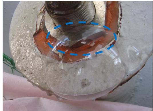
空気漏えいを確認した配管貫通部
