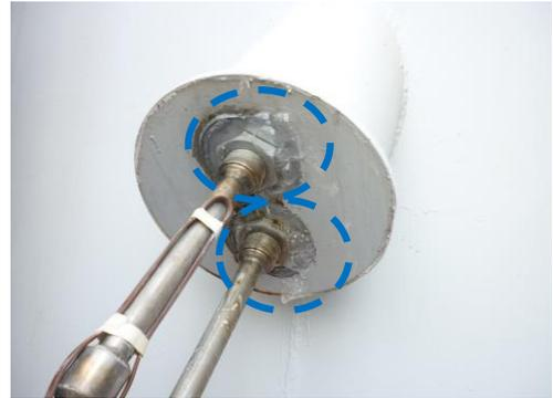
空気漏えいを確認した配管貫通部
