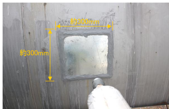
応急処置後(主排気ダクト側)
