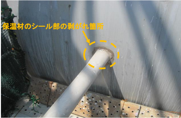
保温材を取り外す前の状況
