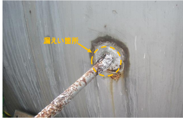
保温材を取り外し後の配管の状況
