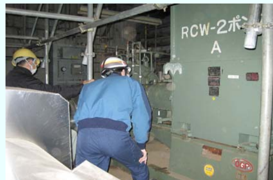
確認運転の様子 【平成24年11月29日本設化完了】 (平成24年11月29日撮影)
