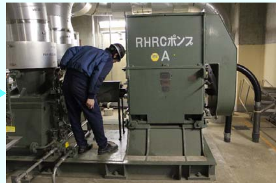
確認運転の様子 【平成24年11月28日本設化完了】 (平成24年11月28日撮影)
