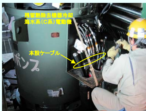
残留熱除去機器冷却海水系ポンプ(C系)電動機 本設ケーブル芯出し作業の様子 (平成24年9月22日撮影)
