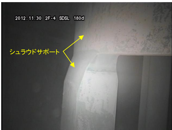
シュラウドサポート [撮影場所：原子炉内] （平成24年11月30日撮影）
