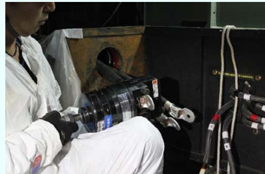
本設ケーブル端子取付作業の様子 (平成24年11月27日撮影)
