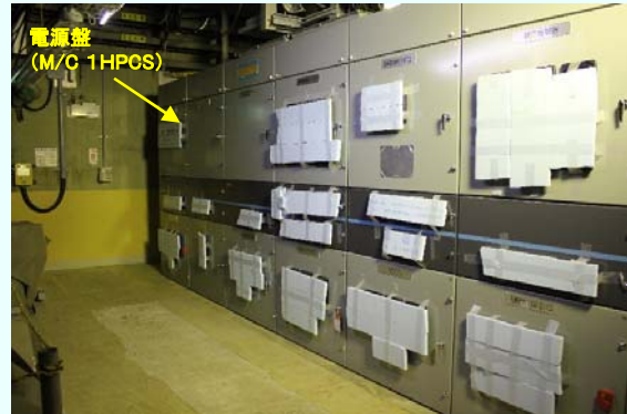
電源盤(M/C 1HPCS)据付完了 【平成24年11月1日据付完了】 (平成24年11月5日撮影)
