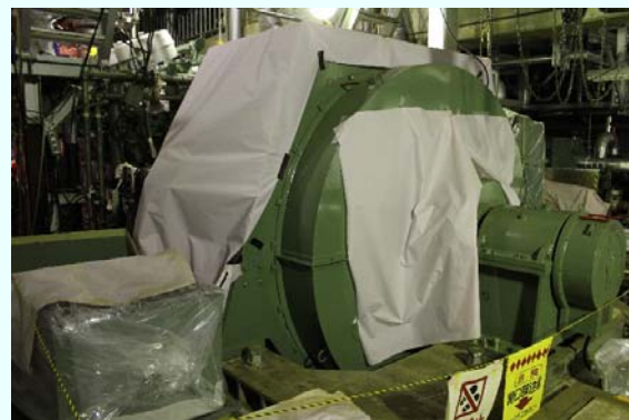
発電機据付完了 【平成24年11月1日据付完了】 (平成24年11月27日撮影)
