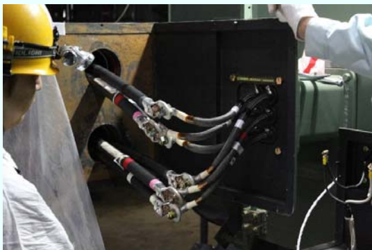
本設ケーブル取付完了 (平成24年11月27日撮影)
