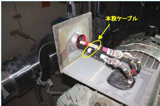
本設ケーブル取付完了 （平成24年11月21日撮影）
