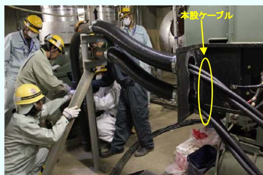
本設ケーブル取付作業の様子 (平成24年11月20日撮影)
