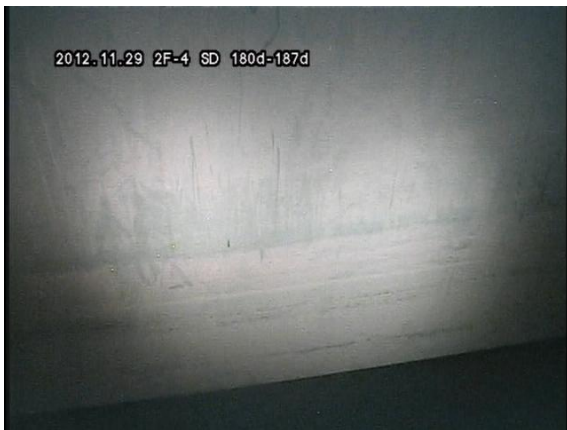
炉心シュラウド（下部・外面） [撮影場所：原子炉内] （平成24年11月29日撮影）
