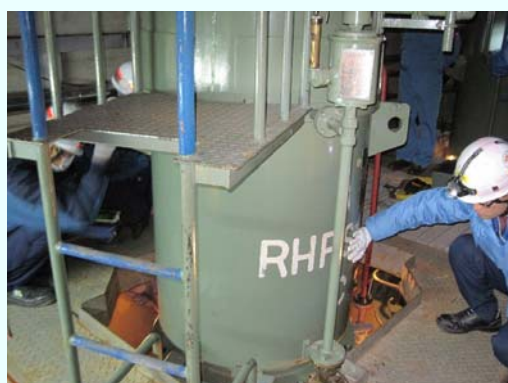
残留熱除去機器冷却海水系ポンプ(C系)電動機 確認運転の様子 【平成24年11月29日本設化完了】 (平成24年11月29日撮影)
