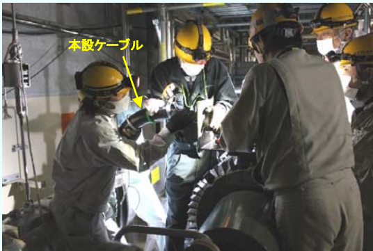
本設ケーブル取付作業の様子 （平成24年11月21日撮影）
