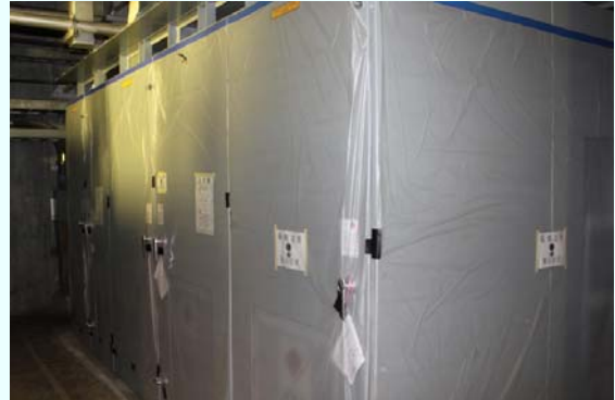
高圧盤据付完了 【平成24年11月9日据付完了】 (平成24年12月4日撮影)
