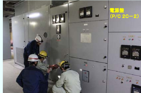
機能確認の様子 【平成24年11月12日機能確認完了】 (平成24年11月12日撮影)
