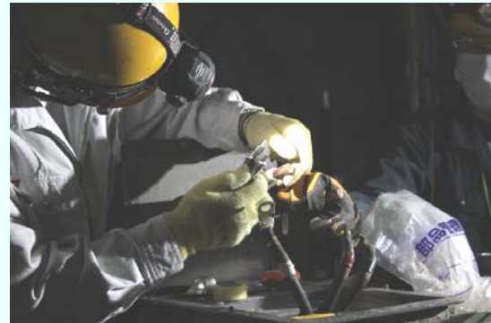
本設ケーブル芯出し作業の様子 （平成24年11月21日撮影）
