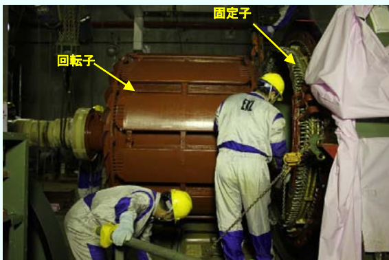
発電機(回転子)の取付作業の様子 (平成24年10月23日撮影)
