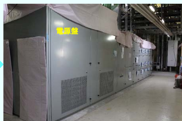
⑤電源盤(P/C 2C-2)据付完了 【平成24年9月11日据付完了】 (平成24年9月26日撮影)
