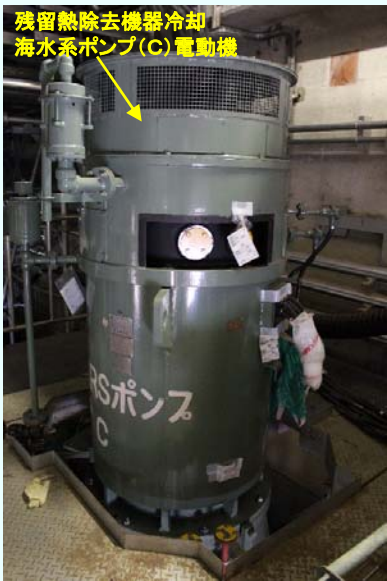
残留熱除去機器冷却海水系ポンプ(C)電動機の据付状況 【平成24年9月13日完了】 (平成24年9月26日撮影)
