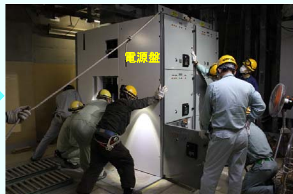
③据付作業の様子 (平成24年9月3日撮影)
