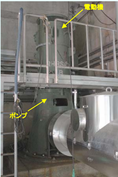
残留熱除去機器冷却海水系ポンプ(B)全景 (平成24年9月26日撮影)
