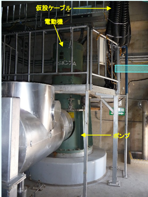
残留熱除去機器冷却海水系ポンプ(A)全景 (平成24年9月13日撮影)
