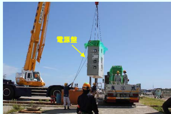
①クレーン車による吊り上げ作業の様子 (平成24年9月3日撮影)
