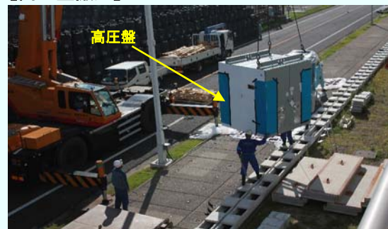
クレーン車による吊り上げ作業の様子 (平成24年9月11日撮影)
