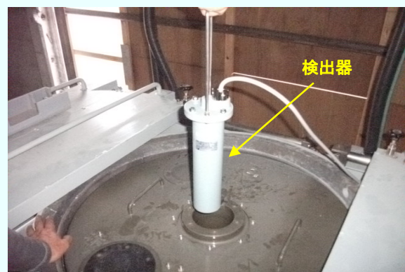
放水口モニタ(検出器)取付の様子 (平成24年9月4日撮影)
