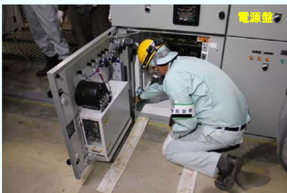
④電源盤固定作業(ボルト取付)の様子 (平成24年9月3日撮影)
