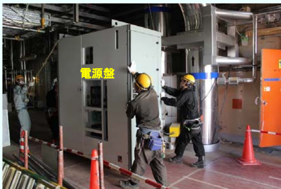
②搬入作業の様子 (平成24年9月3日撮影)
