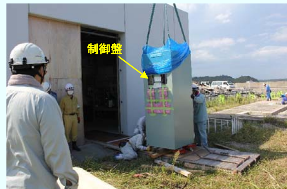
制御盤搬入の様子 (平成24年9月4日撮影)
