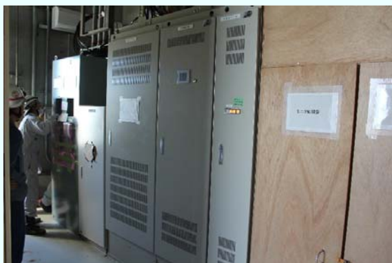
制御盤据付の様子 (平成24年9月4日撮影)
