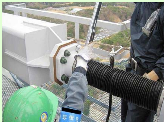
制震オイルダンパーの取付作業 (平成24年4月20日撮影)
