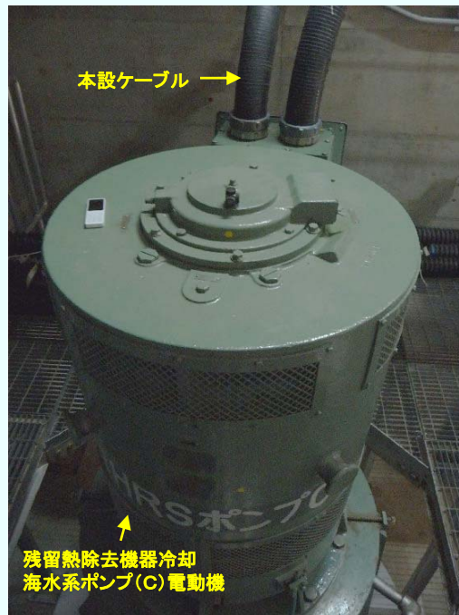
残留熱除去機器冷却海水系ポンプ(C)電動機 本設ケーブルへの切替完了の様子 【平成24年9月11日本設化完了】 (平成24年9月13日撮影)
