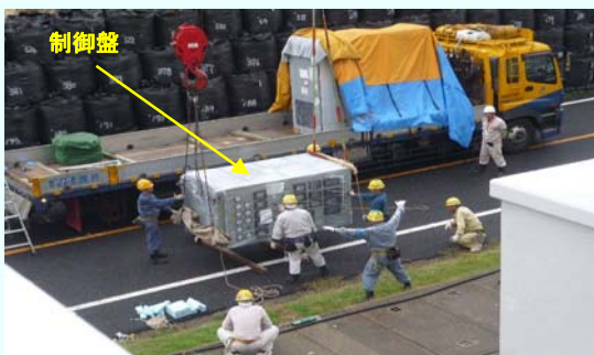
クレーン車による吊り上げ作業の様子 (平成24年9月21日撮影)
