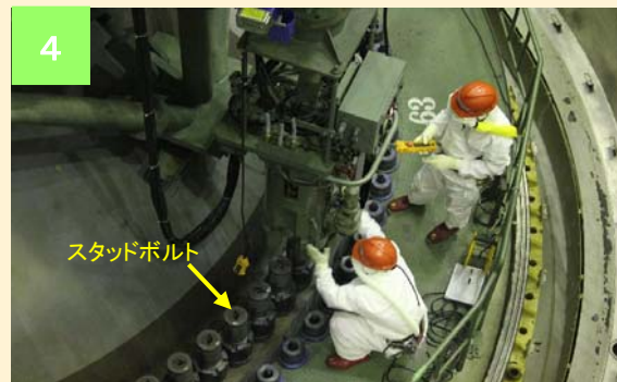
原子炉圧力容器 スタッドボルトの緩め作業の様子 （平成24年9月13日撮影）
