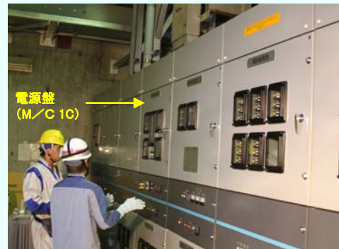
機能確認の様子 【平成24年9月27日機能確認完了】 (平成24年9月27日撮影)
