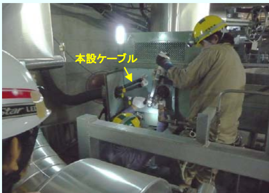
残留熱除去機器冷却系ポンプ(C)電動機 本設ケーブルへの切り替え作業の様子 (平成24年9月13日撮影)
