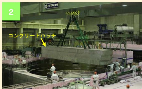
コンクリートハッチの取り外しの様子 （平成24年9月10日撮影）
