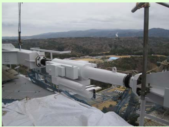
制震オイルダンパーの取付完了 (平成24年4月20日撮影)
