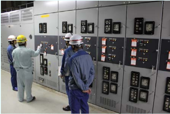
電源盤(P/C 3C-2)の機能確認の様子 【平成24年8月27日本設化完了】 (平成24年8月27日撮影)
