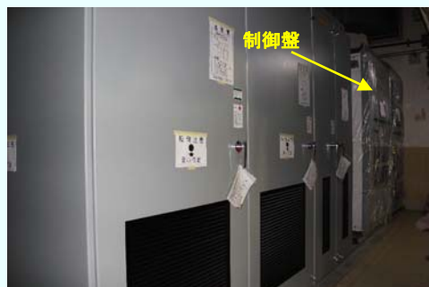
制御盤等の建屋内への搬入完了 【平成24年9月21日搬入完了】 (平成24年9月26日撮影)
