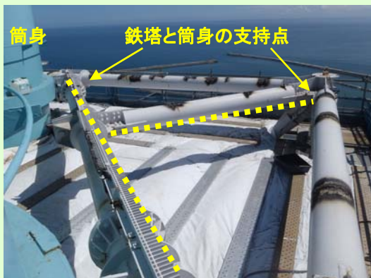
支持点開放前 (平成24年9月5日撮影) 鉄塔と筒身間の支持点を開放する
