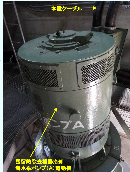
残留熱除去機器冷却海水系ポンプ(A)電動機 本設ケーブルへの切替完了の様子 【平成24年9月11日本設化完了】 (平成24年9月13日撮影)
