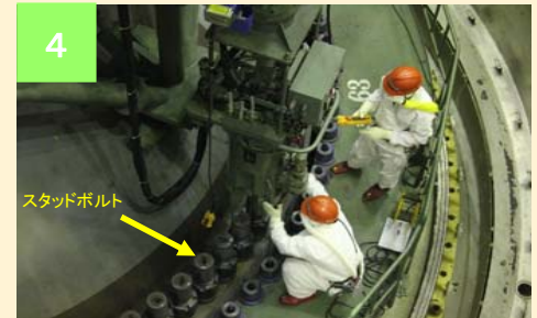
原子炉压力容器 スタッドボルトの緩め作業の様子 (平成24年9月13日撮影)
