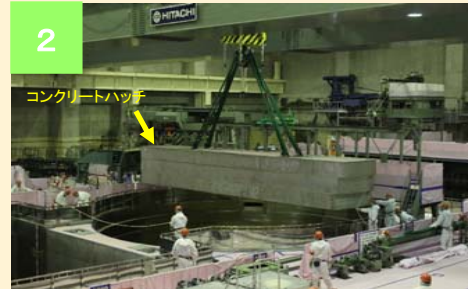
コンクリートハッチの取り外しの様子 (平成24年9月10日撮影)
