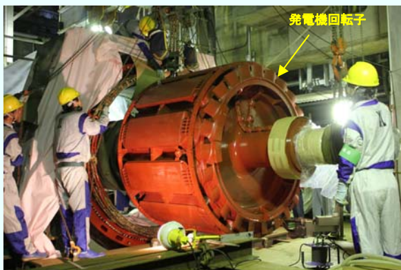
⑤ 発電機固定子への挿入作業の様子 (平成24年8月22日撮影)
