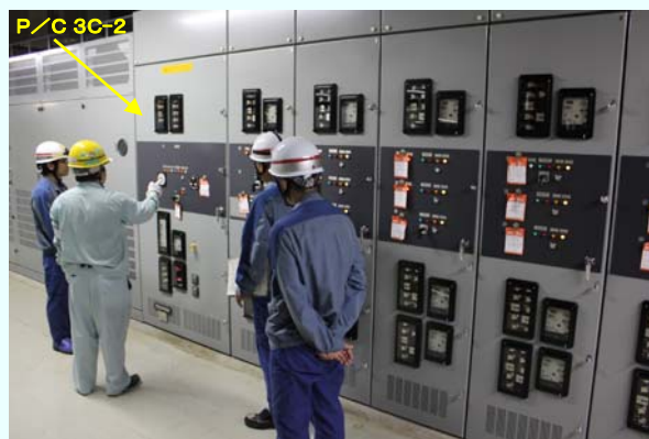
機能確認の様子 (平成24年8月27日撮影)
