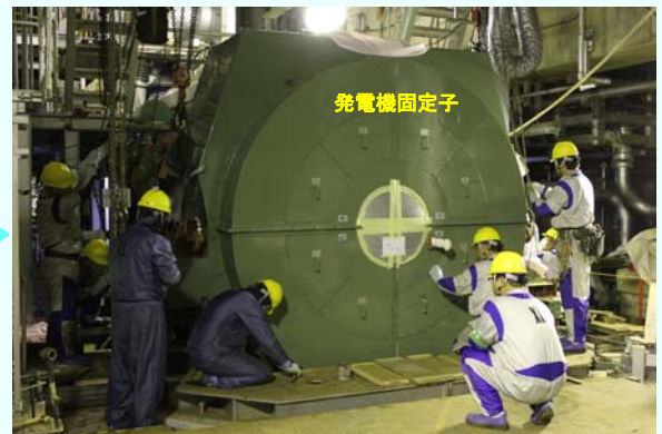
④発電機固定子の据付作業の様子 （平成24年8月8日撮影）
