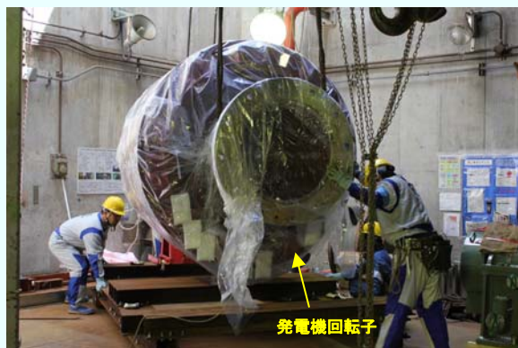
② 建屋内への吊り下げ作業の様子 (平成24年8月20日撮影)
