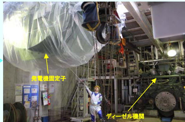
②建屋内への吊り下げ作業の様子 （平成24年8月7日撮影）
