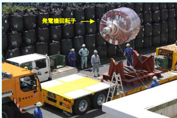
① 発電機回転子の吊り上げ作業の様子 (平成24年8月20日撮影)
