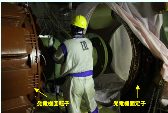
④ 発電機固定子への挿入作業の様子 (平成24年8月22日撮影)
