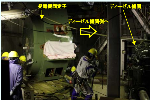
③発電機固定子の移動作業の様子 （平成24年8月8日撮影）
