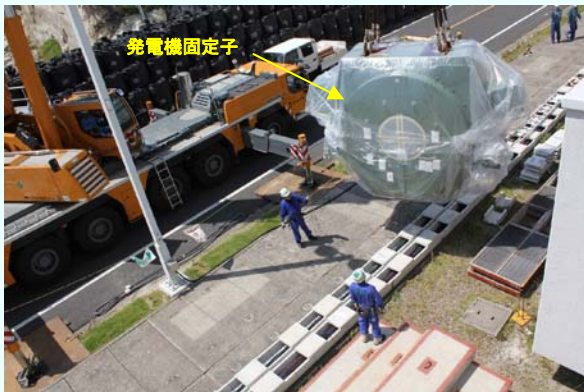
①クレーン車による吊り上げ作業の様子 （平成24年8月7日撮影）
