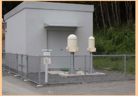
④新設したMP-7 (平成24年7月24日撮影)
