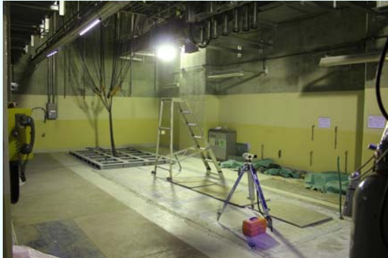
据付前 （平成24年6月8日撮影）
