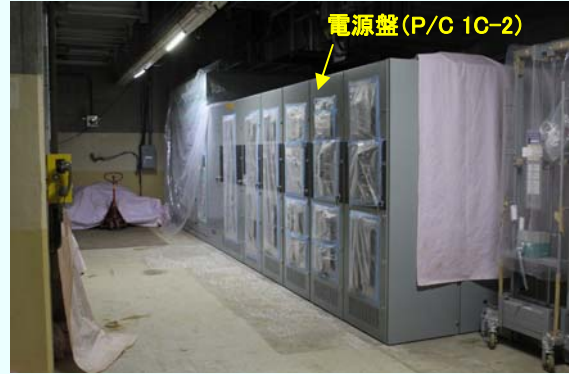
据付完了（平成24年7月10日） （平成24年7月24日撮影）
