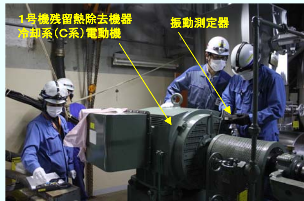
電動機据付後の機能確認 （試運転時の振動測定） （平成24年7月24日撮影）
