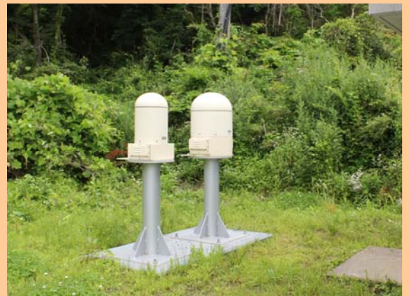
④検出器本体等の取替工事を実施 (平成24年7月23日撮影)
