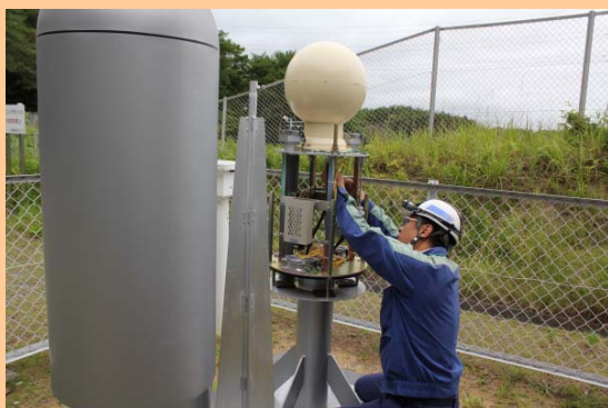
モニタリングポストカバー内部清掃の様子
