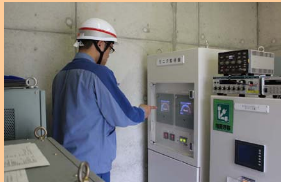
監視盤にて測定値を確認
