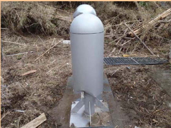
③瓦礫の撤去作業終了後の検出器 (平成23年4月4日撮影)
