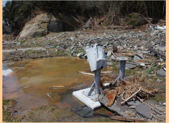
②津波により検出器および建物が流失 (平成23年4月24日撮影)
