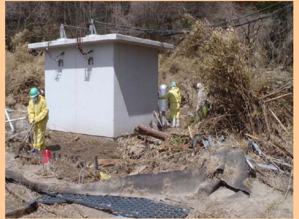
②瓦礫の撤去作業 (平成23年4月4日撮影)
