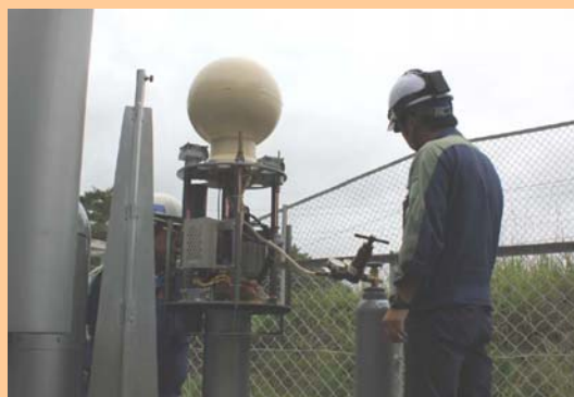
窒素ガス封入の様子
