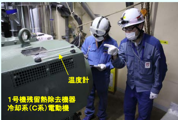
電動機据付後の機能確認 （試運転時の温度測定） （平成24年7月24日撮影）
