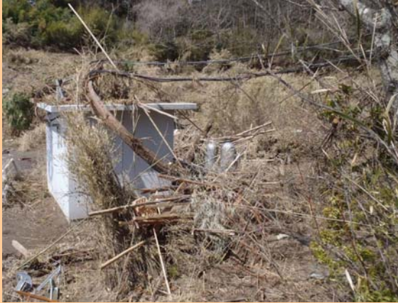
①震災後のMP-6 (平成23年4月3日撮影)
