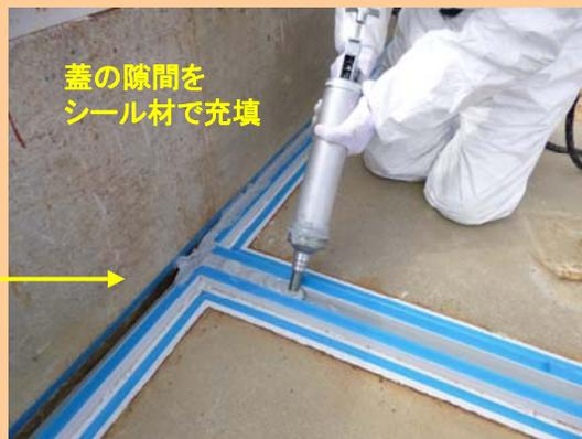
機器ハッチの蓋の隙間をシール材で充填
