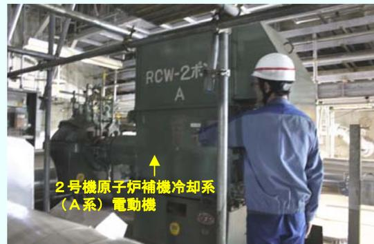
2号機原子炉補機冷却系（A系）電動機
