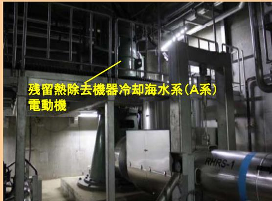
**残留熱除去機器冷却海水系（A系）電動機**
