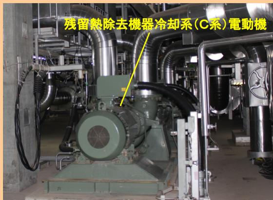
**残留熱除去機器冷却系（C系）電動機**
