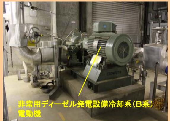
非常用ディーゼル発電設備冷却系 (B系) 電動機
