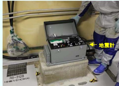
地震計の据付状況(1号機原子炉建屋2階)
