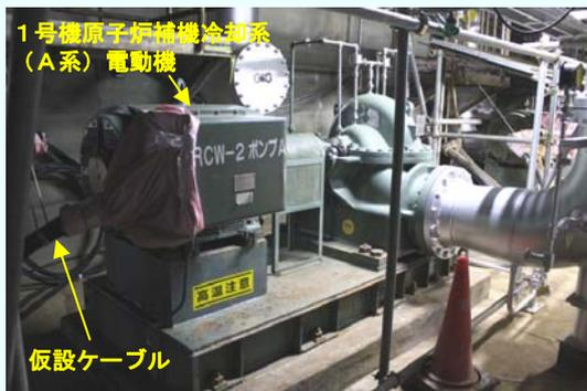
1号機原子炉補機冷却系（A系）電動機
