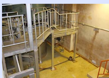
1号機タービン建屋地下1階復水器室の現況 (平成24年5月24日撮影)
