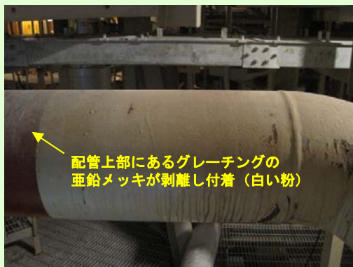
⑪グレーチングの亜鉛メッキ剥離（白い粉） (平成24年4月17日撮影)
