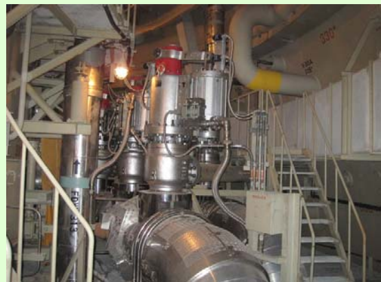
②原子炉格納容器内の状況 (主蒸気逃がし安全弁) (平成24年4月17日撮影)
