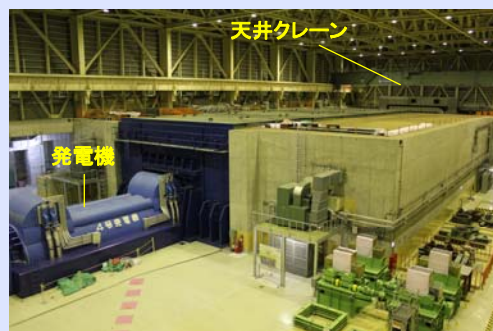
4号機タービン建屋2階フロアの現況 (平成24年5月15日撮影)
