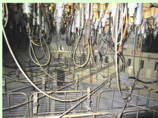
⑧ペDESTAL部 (原子炉圧力容器の基礎台) (平成24年5月10日撮影)
