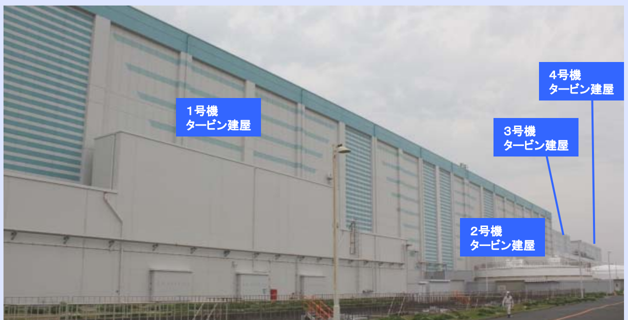
タービン建屋の外観 (平成24年5月25日撮影)
