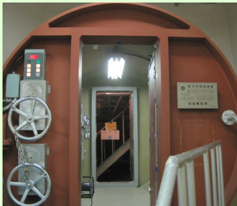
①原子炉格納容器入口 (所員用エアロック) (平成24年5月10日撮影)
