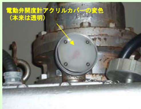
⑫電動弁開度計アクリルカバーの変色 (平成24年3月13日撮影)
