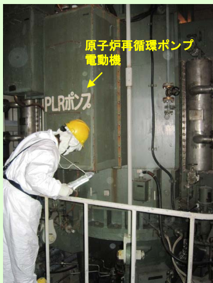
⑤目視点検の様子(その1) (平成24年5月10日撮影)
