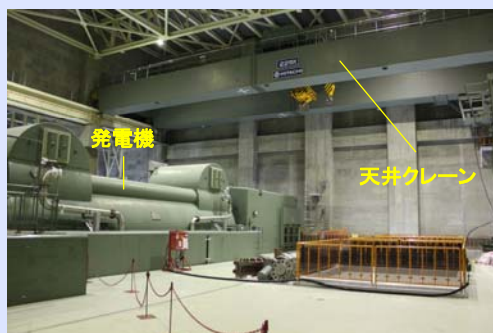
2号機タービン建屋2階フロアの現況 (平成24年5月15日撮影)
