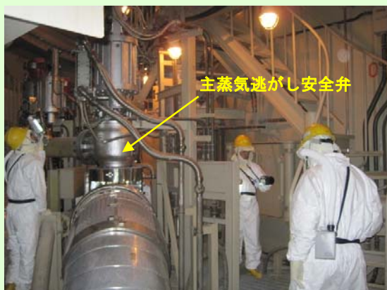
⑦目視点検の様子(その2) (平成24年5月10日撮影)
