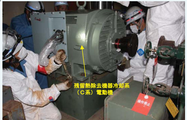
残留熱除去機器冷却系 (C系) 電動機の据付作業 (拡大) (1号機海水熱交換器建屋1階) (平成24年5月22日撮影)
