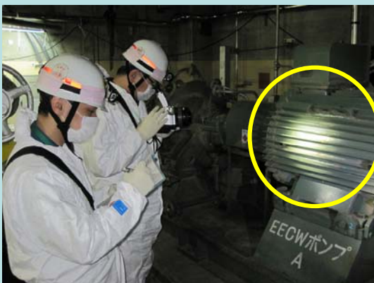
赤外線サーモグラフィ診断 (平成24年3月28日撮影)
