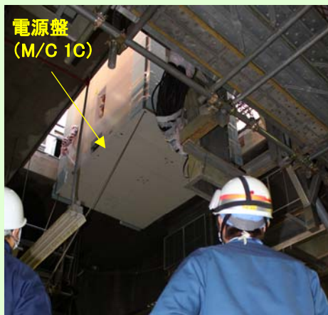
②吊り込み作業 (据付場所へ吊り下げ) (平成24年3月15日撮影)
