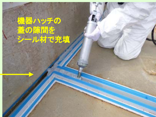
蓋の隙間をシール材で充填 (平成24年3月23日撮影)
