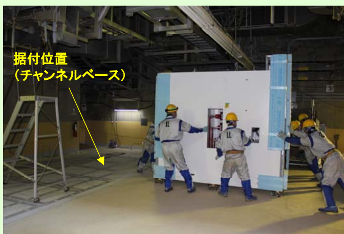
③吊り下げ後の移動作業 (平成24年3月15日撮影)
