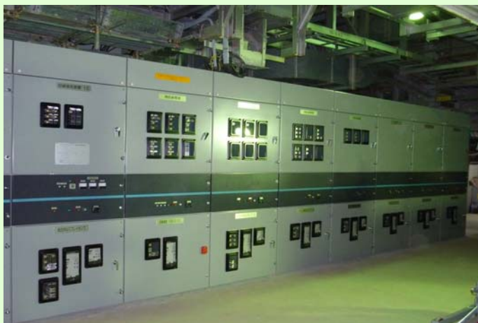
④電源盤 (M/C 1C) 据付完了 (平成24年3月28日据付完了) (平成24年4月2日撮影)
