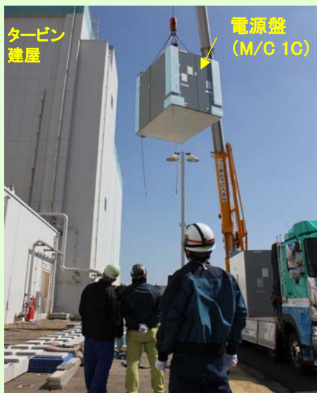
①吊り込み作業 (平成24年3月15日撮影)
