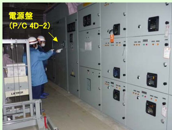
機能確認の状況 (平成24年3月23日機能確認・本設化完了) (平成24年3月23日撮影)
