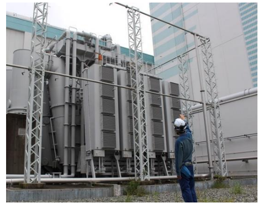
解体撤去予定の主変圧器を点検している様子（9月15日撮影）
