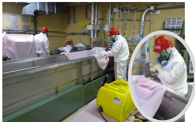
噴射法（高圧水）による3号炉の除染作業の様子（8月19日撮影）
