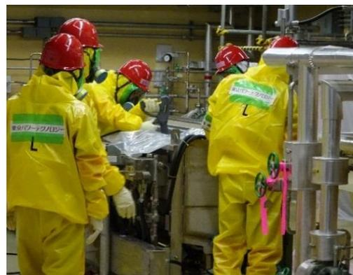
CRD半自動分解装置内部を噴射法にて除染している様子（7月6日撮影）
