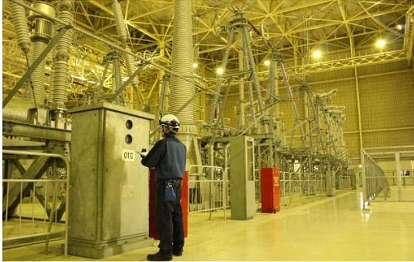
送電線から受電した電気を発電所内に送る中継点（開閉所）のパトロール
