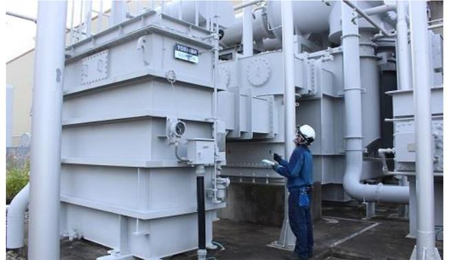
送電線から受電した電気の電圧を変える設備（起動用開閉所変圧器）のパトロール
