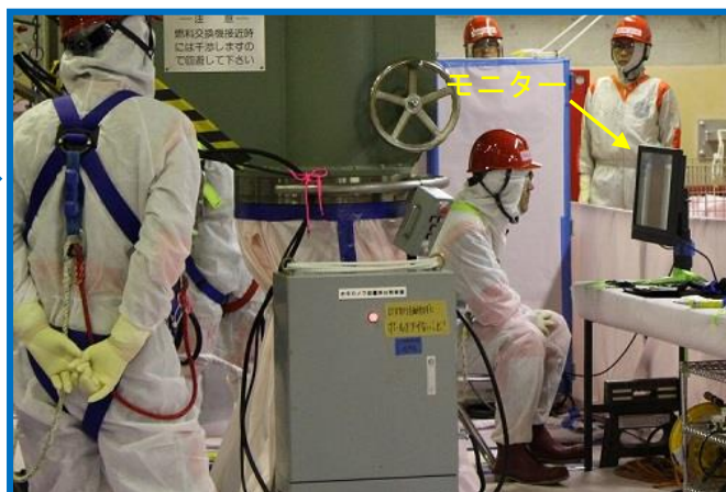
水中カメラで撮影した燃料集合体の状態をモニターで確認
