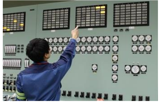
中央制御室での監視（設備の状態を確認）
