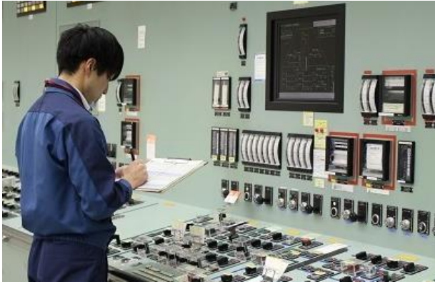
中央制御室での監視（データの採取）
