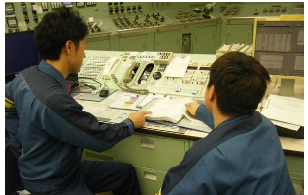
現場の状況等について交代する運転員へ引き継ぎ
