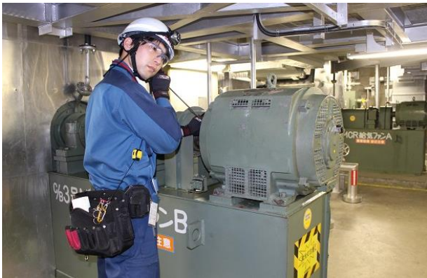
直接機器に触れて運転状態を確認
