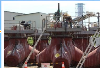
コンクリート流し込み
