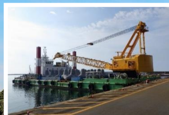
クレーン船にて海上運搬
