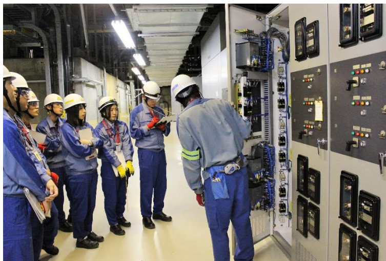
電源盤内の機器操作について先輩社員から学ぶ
