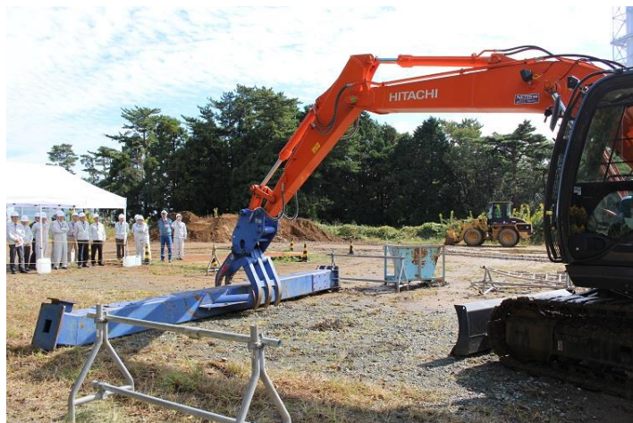
重機を使ったガレキ撤去訓練を確認いただきました
