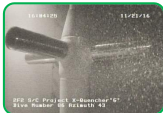
スパージャー (原子炉の蒸気を排気する管)
