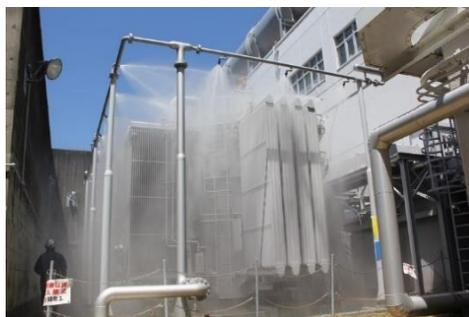
変圧器類焼防止装置の起動確認試験
