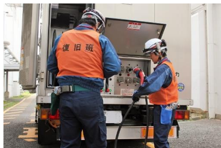
電源確保に向けた電源車の操作
