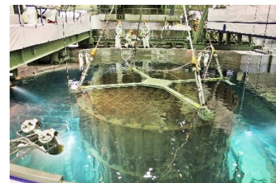
気水分離器の原子炉内移動
