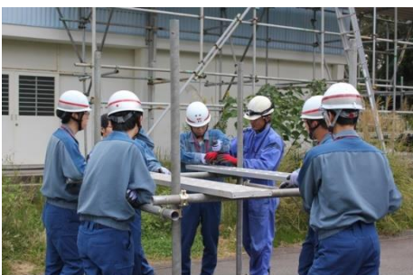
足場の組み立て
