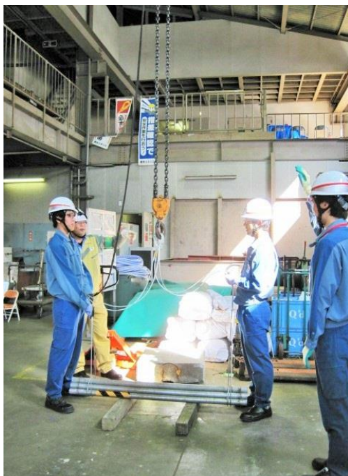
重量物の吊り上げ
