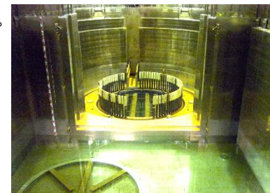
水抜き作業完了後の様子
