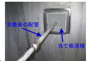
補修後の状況
