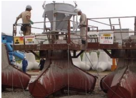
型枠へのコンクリート流し込み
