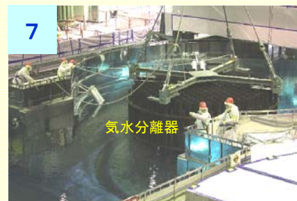
気水分離器の取り外し (平成27年2月26日撮影)
