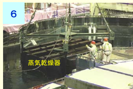
蒸気乾燥器の取り外し (平成27年2月25日撮影)
