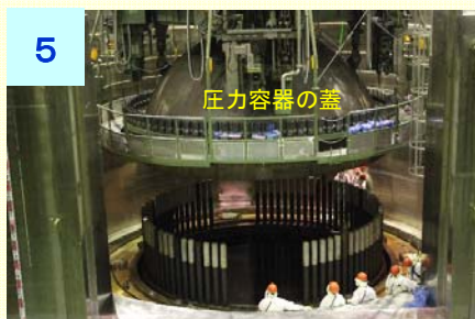
原子炉圧力容器 蓋の取り外し (平成27年2月23日撮影)
