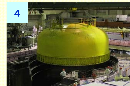
原子炉格納容器 蓋の取り外し (平成27年2月16日撮影)
