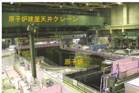
コンクリートハッチの取り外し後
