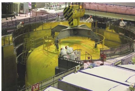
原子炉格納容器のふたの吊り上げ
