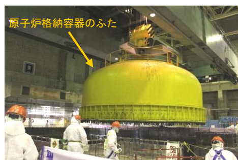
原子炉格納容器のふたの移動
