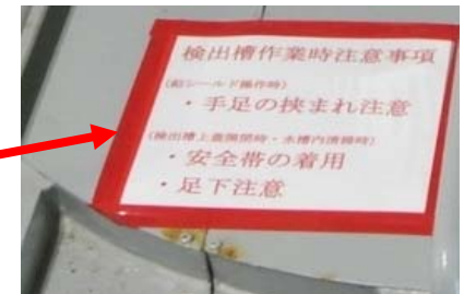
是正措置後 作業時の注意事項の掲示
