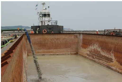
被覆材を船に積み込んでいる様子
