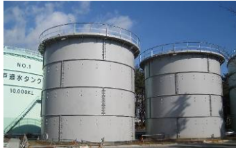
確認試験を行っているフランジ型タンク
