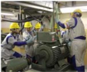
写真は、津波の被害によりモータが使えなくなった場合でも、すみやかに復旧できるよう「モータ取替チーム」がモータを取り替える訓練を行っている様子です。
