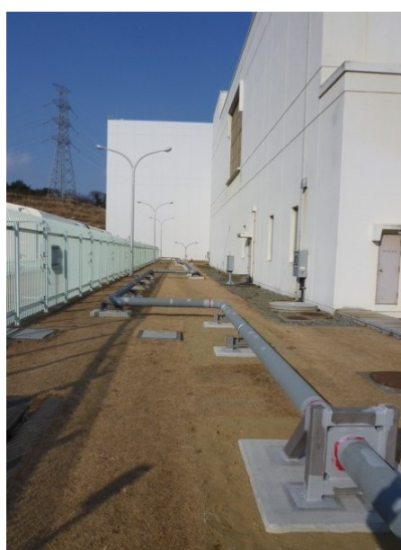
第 8.1.2-3 図 消火配管の地上化
