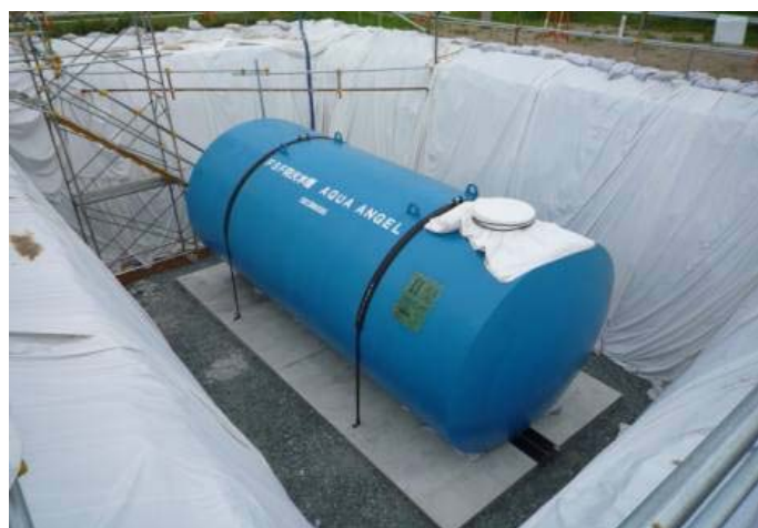
第 8.1.2-4 図 防火水槽の設置
