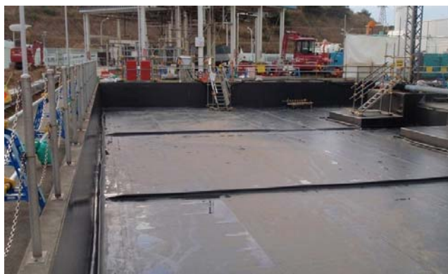
第 8.2-2 図 防油堤の油漏えい対策 (遮水シートの敷設)
