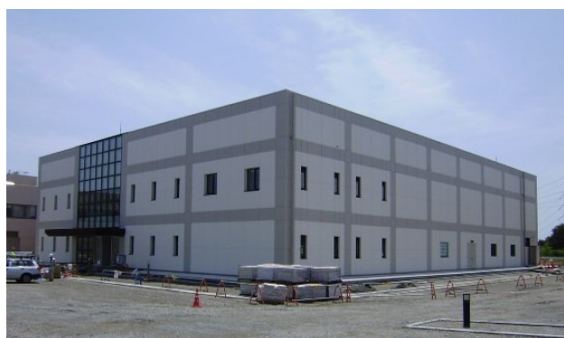
第 8.1.2-1 図 緊急時対策室の設置
