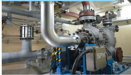
高圧系のECCSが起動・運転継続できない場合、あるいはすべての電源を失った場合に、原子炉の蒸気を駆動源にしてポンプを回し原子炉へ注水します。
