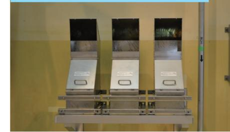
電気を使わずに触媒の働きにより、水素と酸素を水蒸気に変え水素濃度の上昇を抑えます。原子炉建屋最上階に設置しています。
