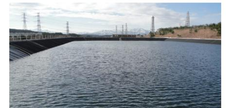
原子炉などに供給する冷却水の水源を強化する目的で、海抜約45mの高台に設置しました。貯水容量は約2万トン。
