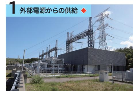
発電所外部から必要な電力を受電できるように、外部電源(送電線)を5回線用意しています。
