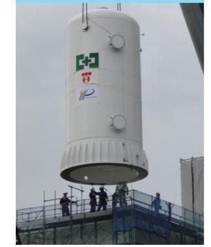
格納容器内に滞留するガスをフィルタベント設備を通して大気に逃がすことで、粒子状放射性物質および無機よう素の99.9%以上を除去します。また、よう素フィルタにより有機よう素の98%以上を除去します。
