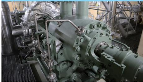
電源駆動のポンプや原子炉の蒸気を駆動源としたポンプを用いて原子炉へ注水します。
