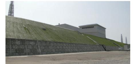
海抜12mの敷地にセメント改良土で高さ約3mの盛土をした堤防（敷地の高さ合わせて海抜15m）を約1km設置しています。
