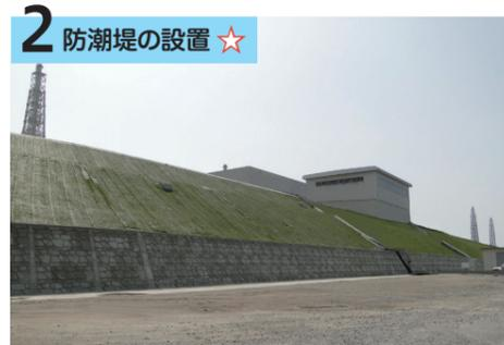
柏崎刈羽原子力発電所で想定される津波の高さは約7～8mですが、海拔12mの敷地にセメント改良土で高さ約3mの盛土をし、海拔15mの防潮堤を建設しました(5～7号機側)。
