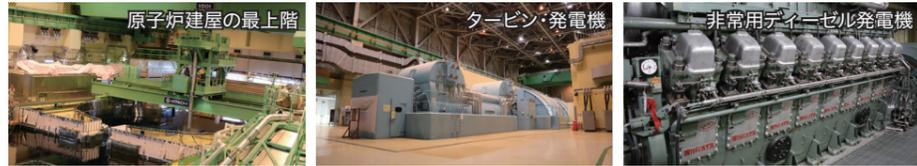
原子力発電所は、原子炉を設置している原子炉建屋、タービン・発電機を設置しているタービン建屋などから構成されています。原子炉建屋には、何らかの異常により発電所内の電源供給が停止した場合を想定し、発電所内で必要な電力を供給できる非常用ディーゼル発電機を設置しています。
