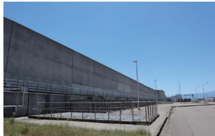
海抜5mの敷地に高さ約10mの鉄筋コンクリート製の堤防（敷地の高さ合わせて海抜15m）を約1.5km設置しています。
