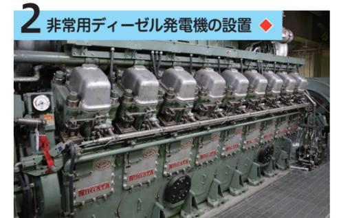
外部電源が喪失した場合に起動し、原子炉を安全に停止するための電力を供給します。隣接号機への供給も可能です。
