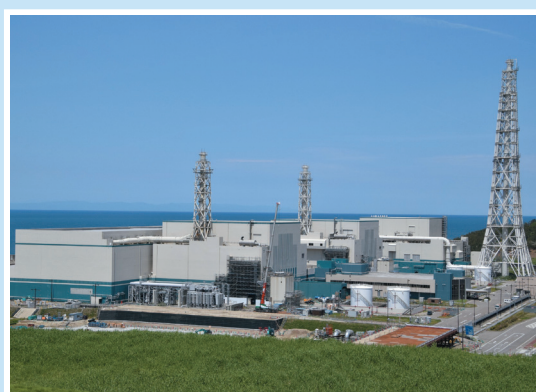
発電所全景（5～7号機側）
