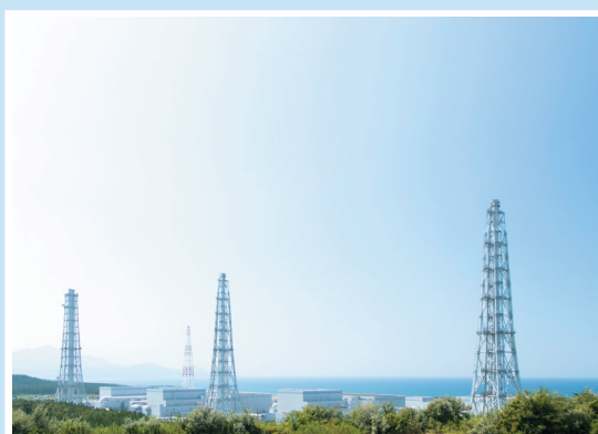
発電所全景（1～4号機側）
