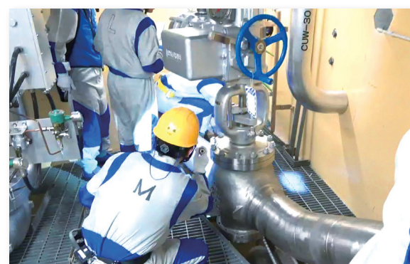
設備が機能を発揮できるか確認する様子
